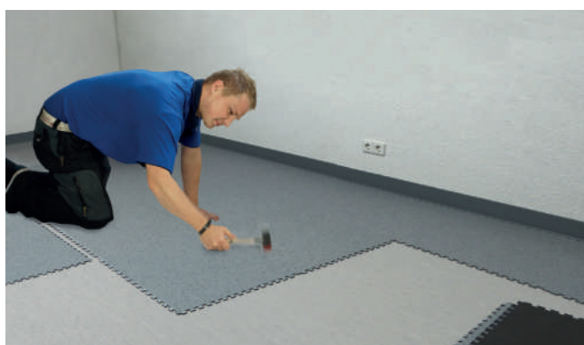
Układanie przy użyciu gumowego młotka
